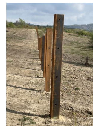
Enfouissement et alignement des poteaux délimitant les futurs enclos extérieurs
