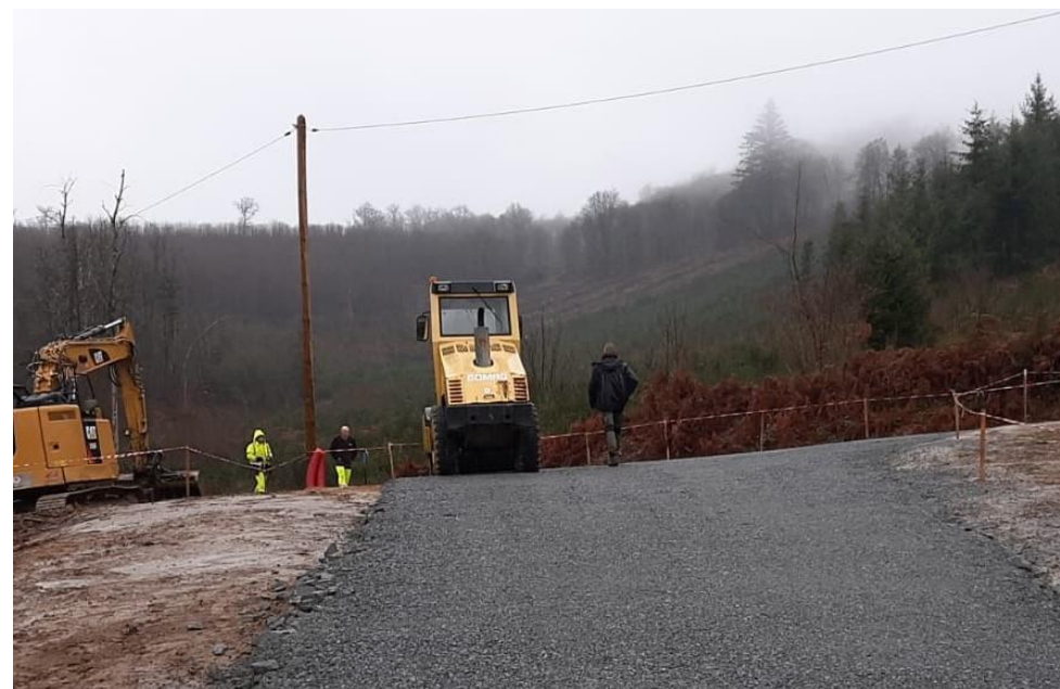
Création d'une piste d'accès à l'emplacement présumé de la 2 e étable
